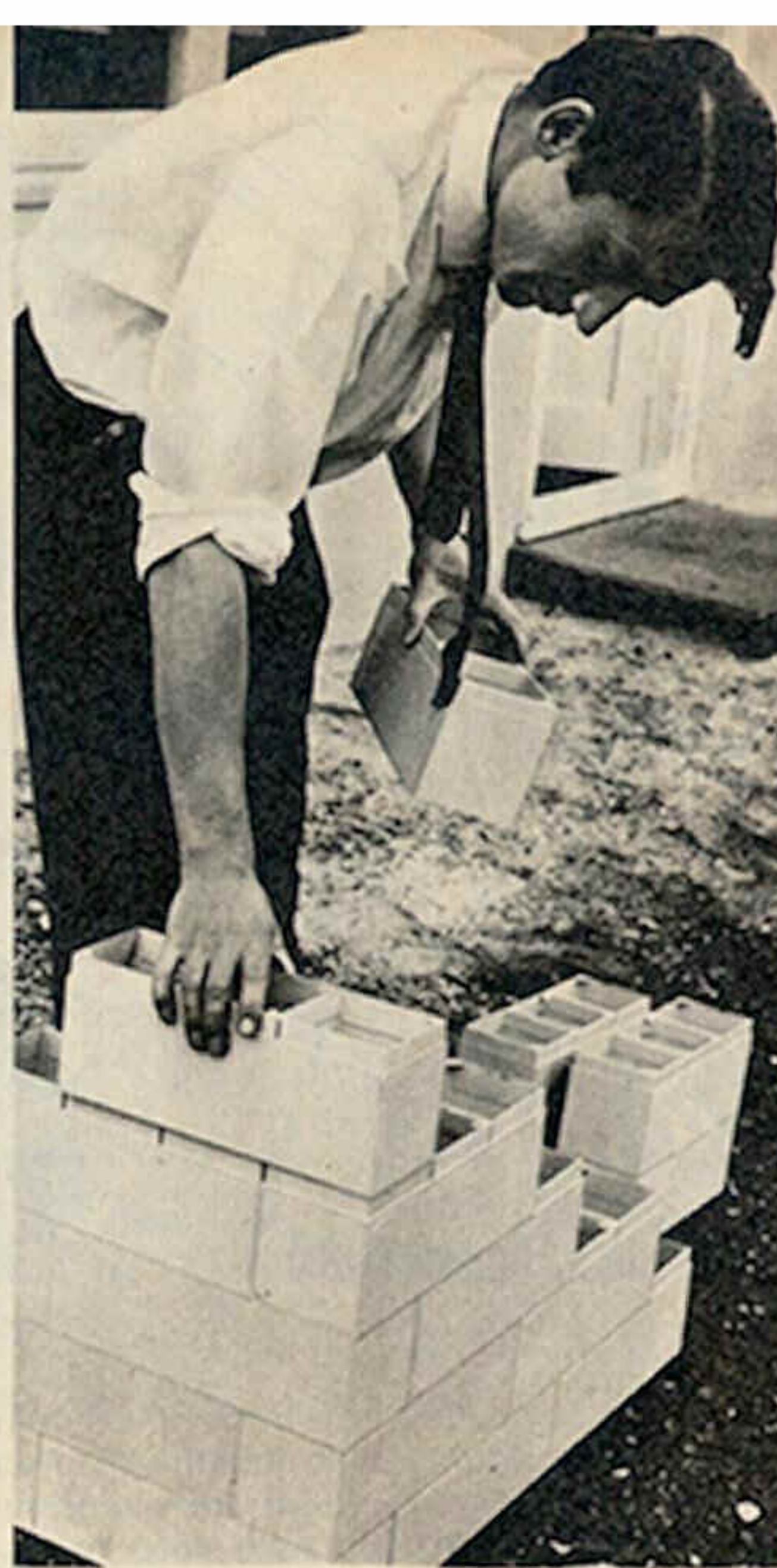
El plástico ya incorporado, en ladrillos.
