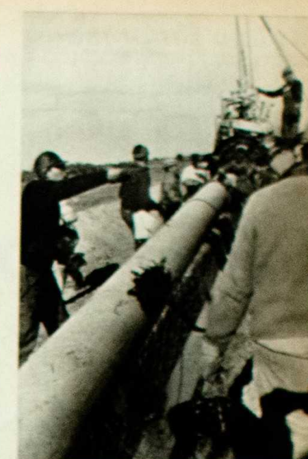
INSTALACION DE OLEODUCTO El trasporte de la riqueza
