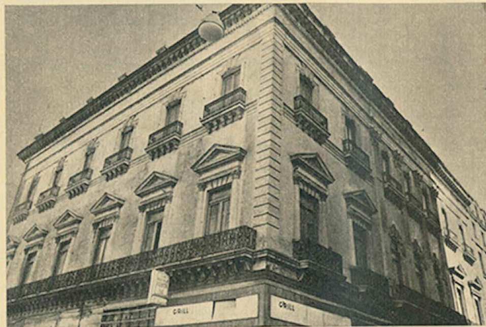
LA ESQUINA, ANTES DE LA DEMOLICION
