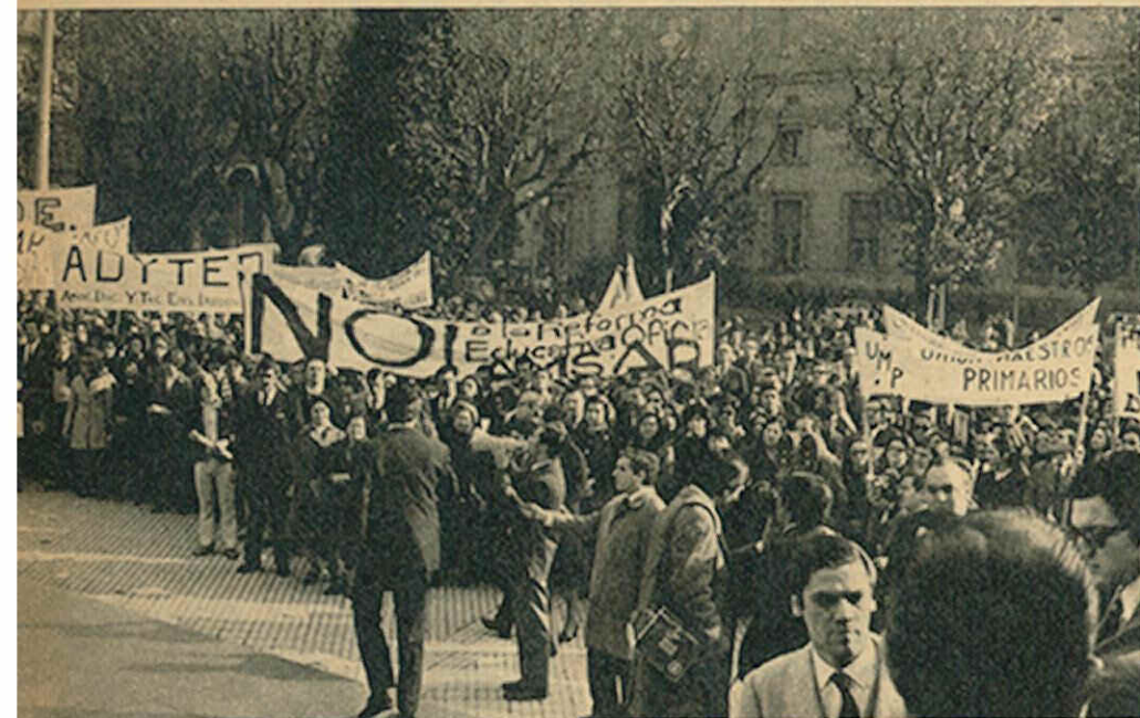
CONCENTRACION EN PLAZA DE MAYO
