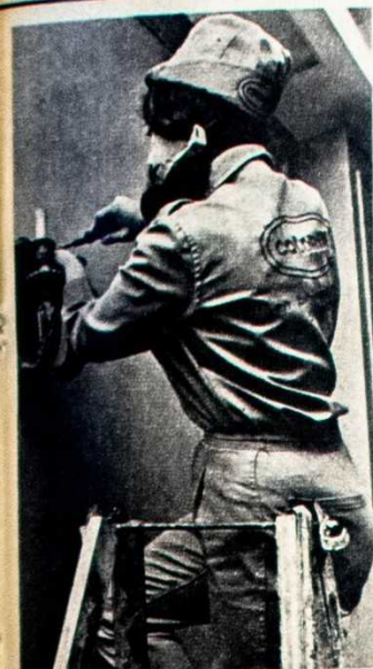
Pintura, enduldo y... a la obra.
