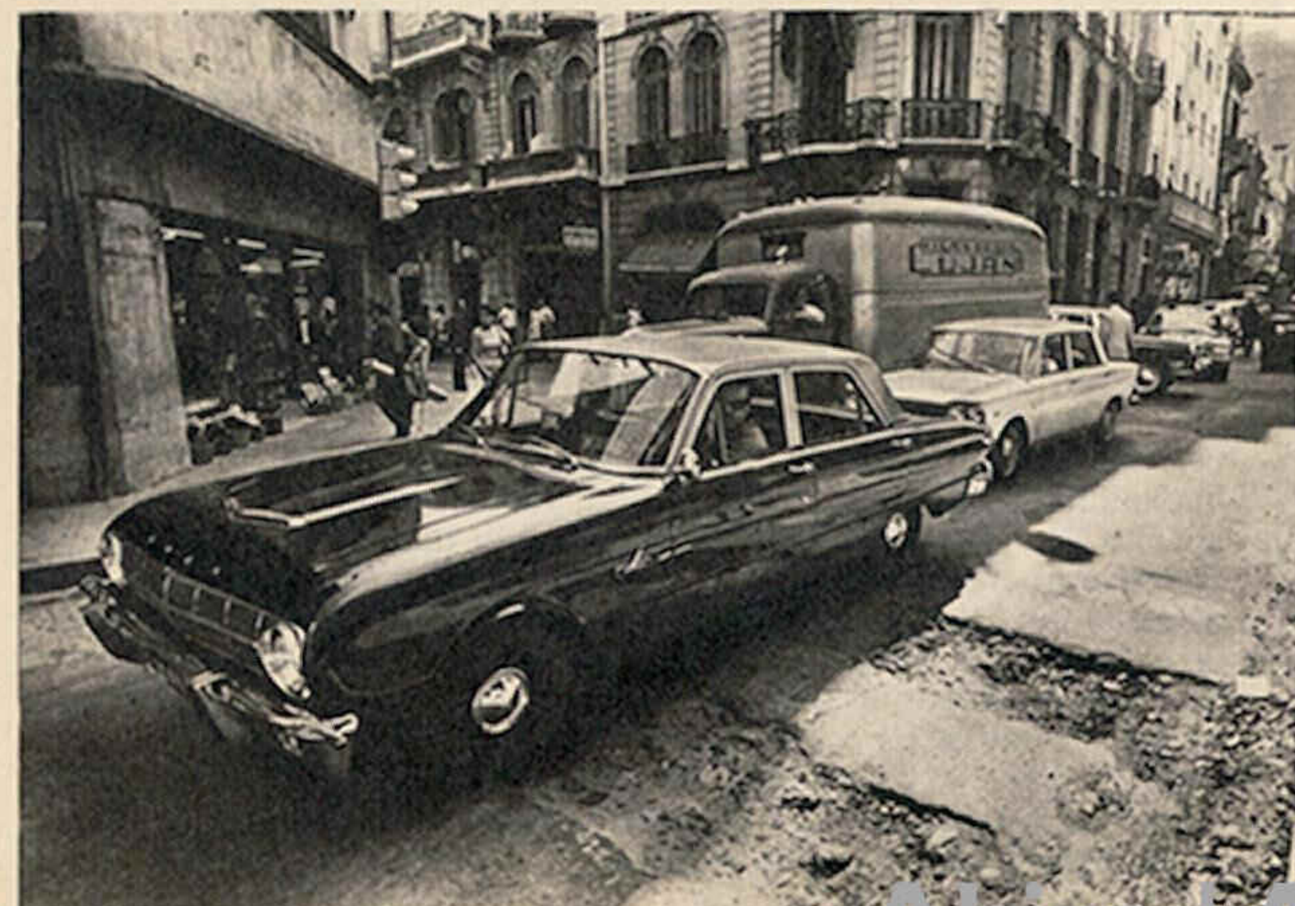
Pavimentos deteriorados: cada vez más autos, que anclan el tráfico sobre ellos.
