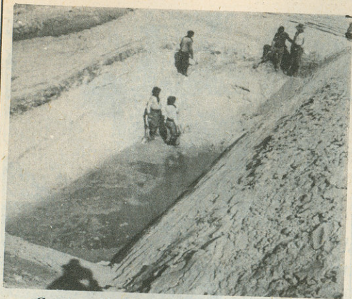
Construcción del puerto de Santa Fe 1910
