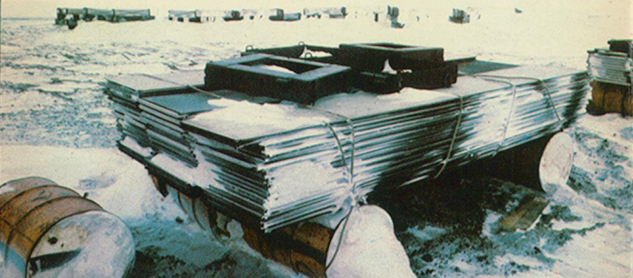
Los paneles de aluminio que conformarán la futura pista de Marambio, donde podrán aterrizar jets.
